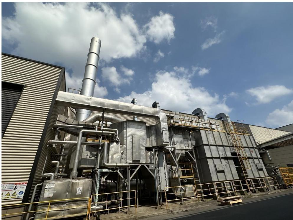
**1号RTO炉+20米高排气筒DA001 ( 2号车间)**
