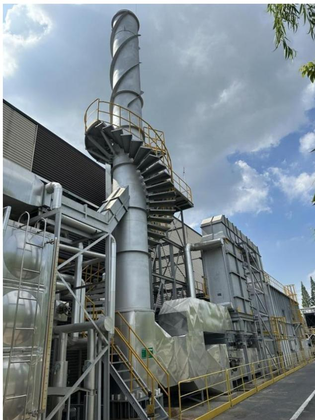
**2号RTO炉+18米高排气筒DA002 (1号车间)**
