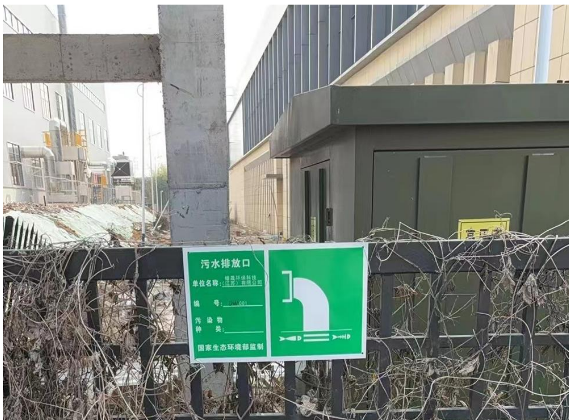
图4.1-1 厂区污水排放口
