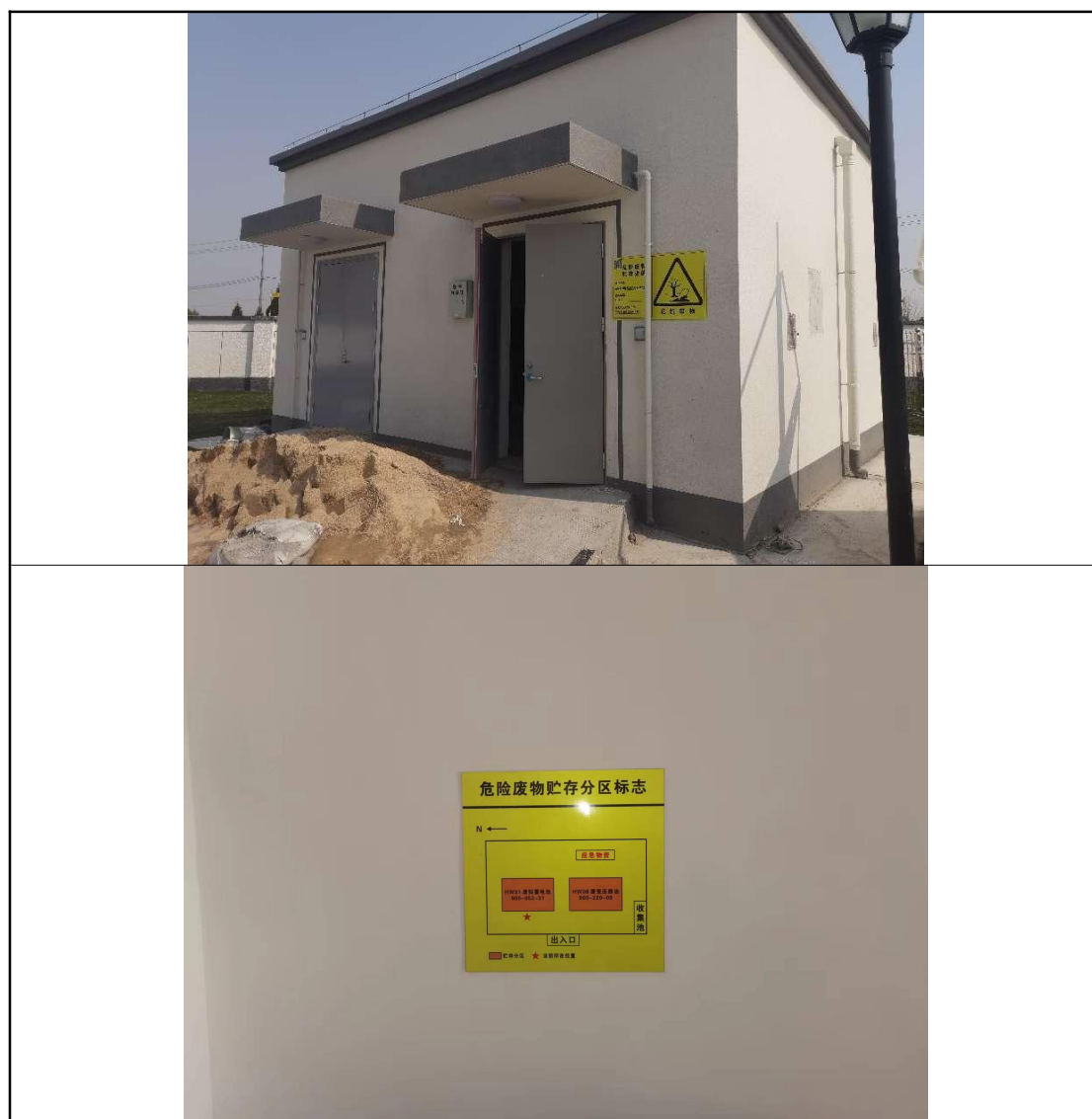
图 8-1 危废储存间照片
