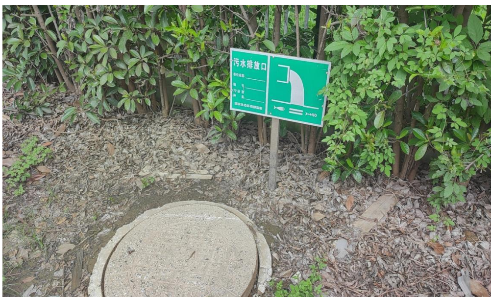
图 4.1-1 厂区污水排放口
