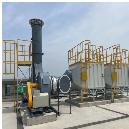
有机废气收集管道装置+二级活性炭装置+排气筒
