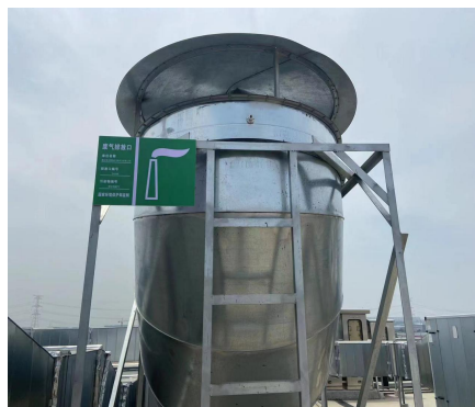
粉尘收集管道装置+布袋除尘装置+排气筒
