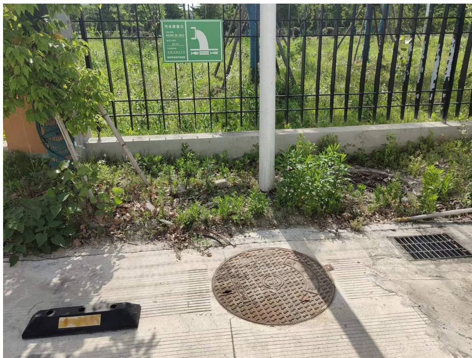
图 3-1 厂区污水接管口
