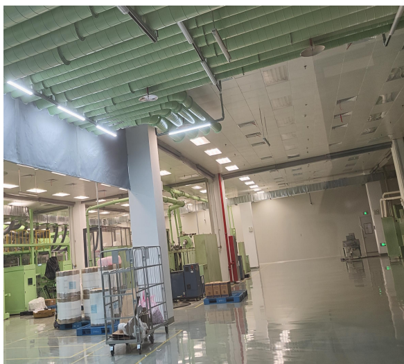
有机废气收集管道装置+二级活性炭装置+排气筒
