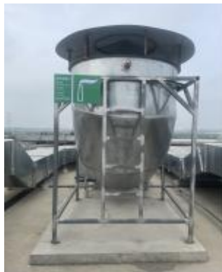
粉尘收集管道装置+布袋除尘装置+排气筒
