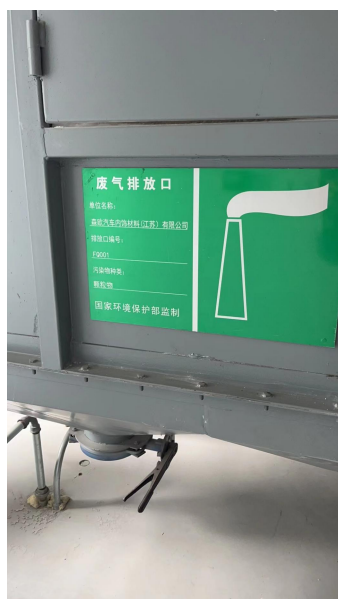
1#排气筒标识牌
