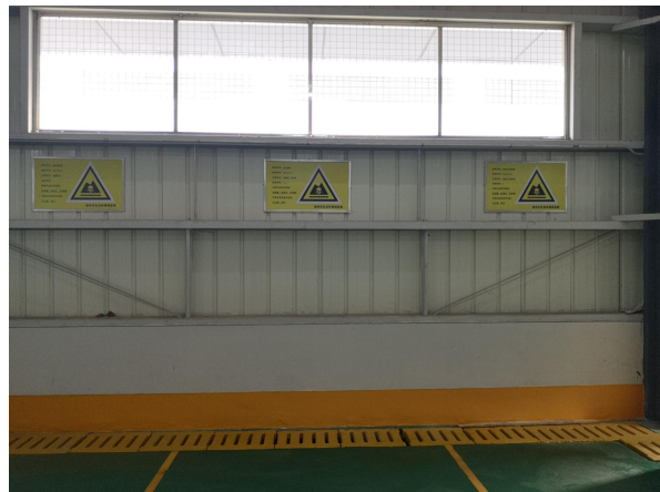
危废库内部分区及导流槽
