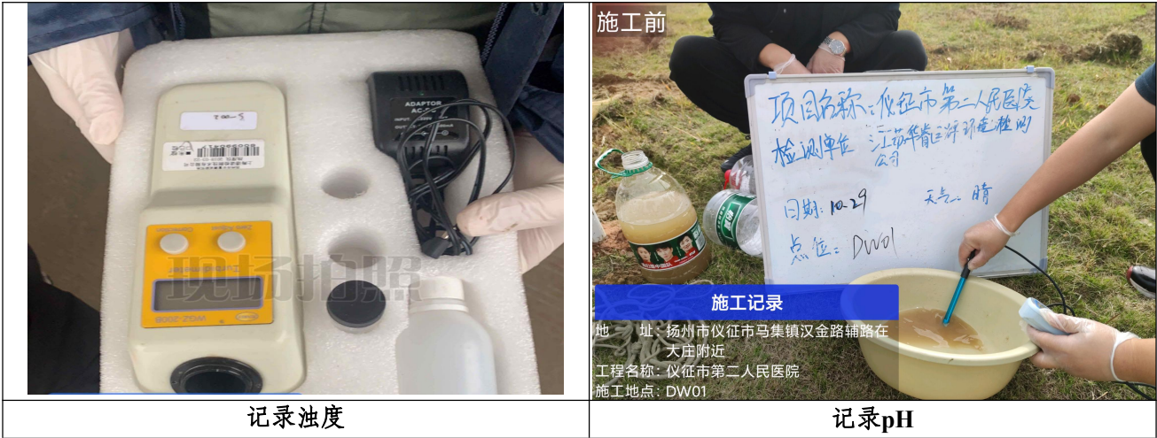
图5-10 采样前洗井快速检测照片
