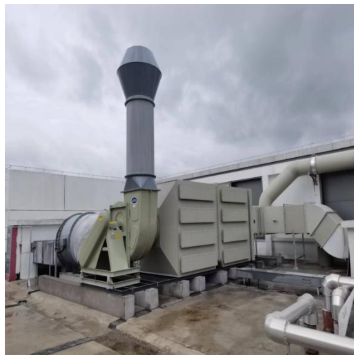
质检楼 4#排气筒
