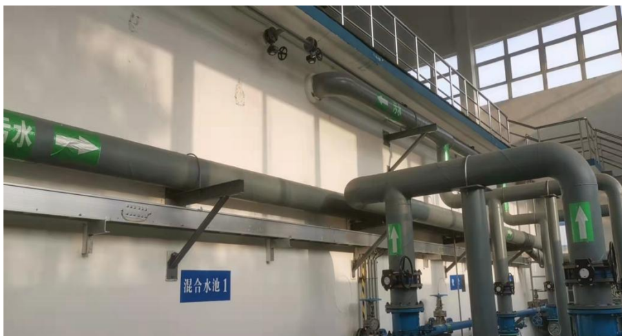
收集、混合池混凝土加盖
