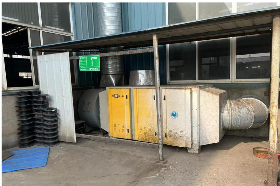
图 3-5 有机废气去除装置
