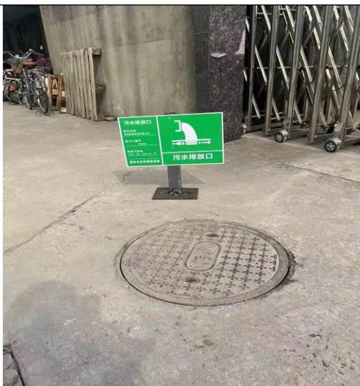
图 3-2 污水接管口
