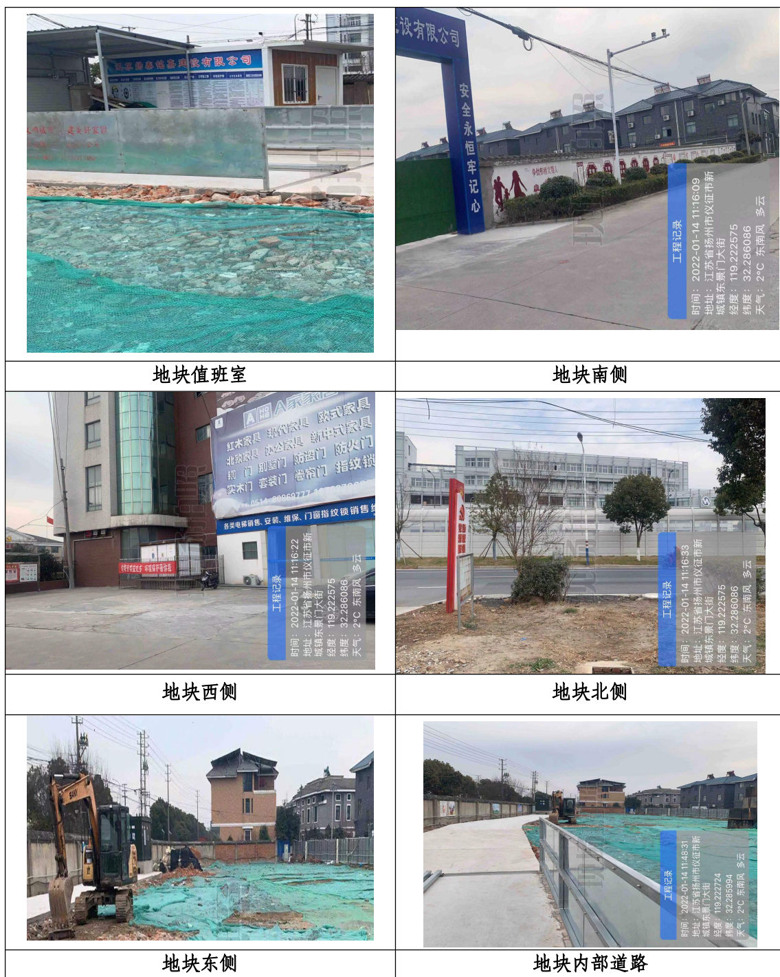
图4-1 现场踏勘照片
