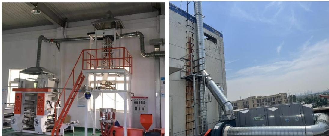
检测废气收集装置
