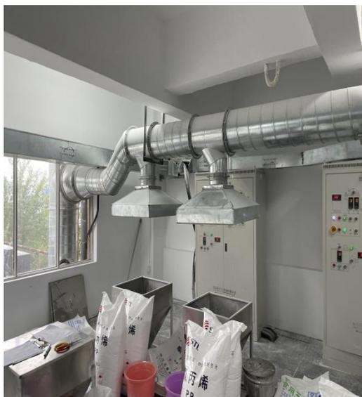
投料废气收集装置
