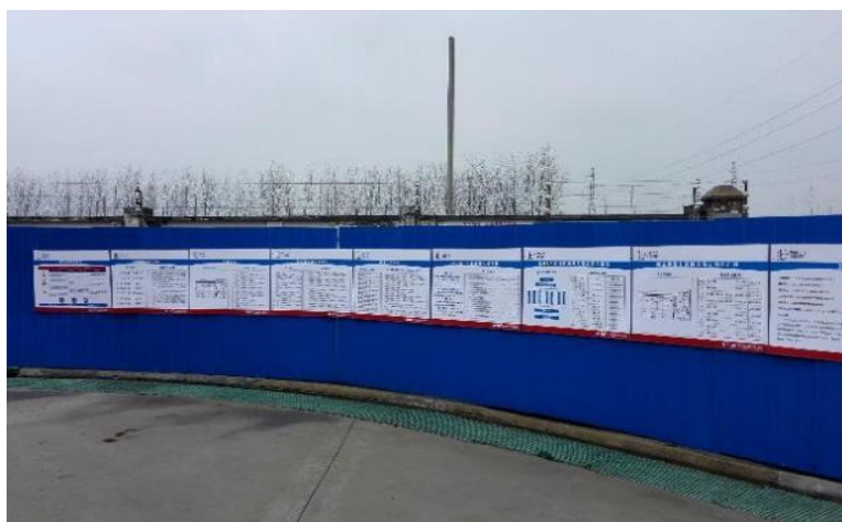
施工场地围挡及宣传展示牌
