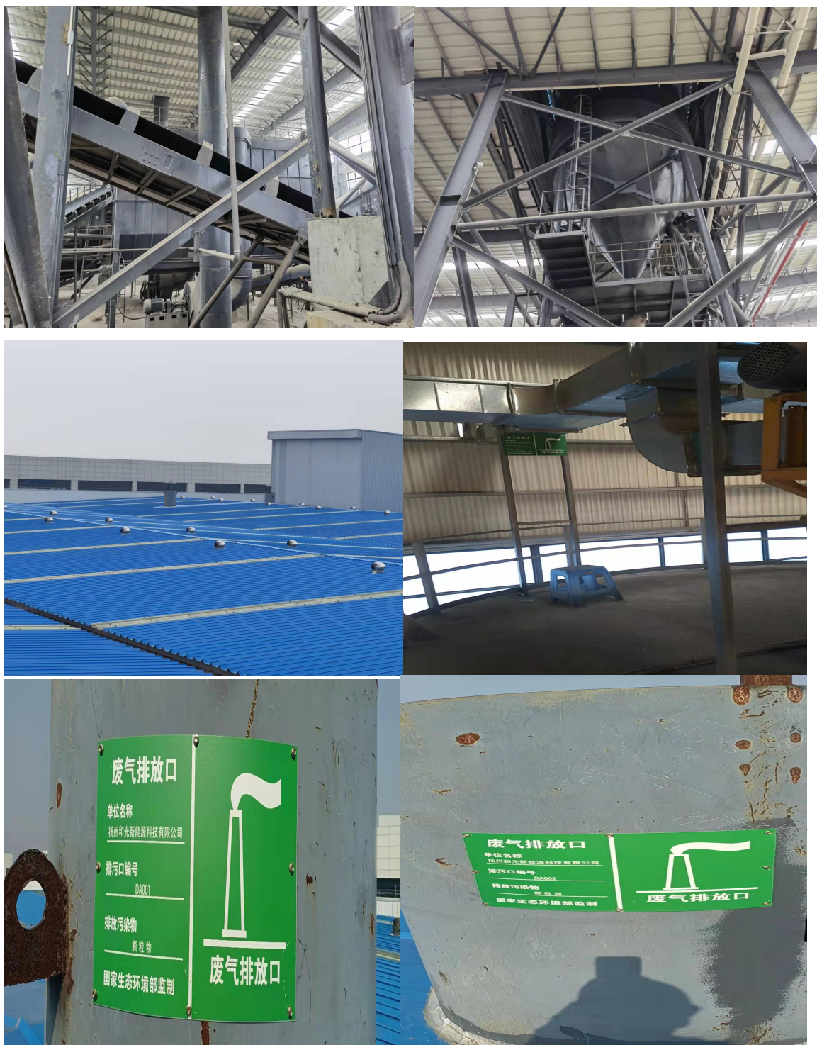
图 3-2 废气处理装置及环保标志牌
