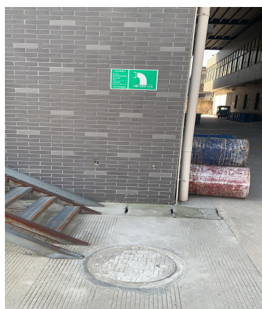
图3-2 污水接管口标识牌
