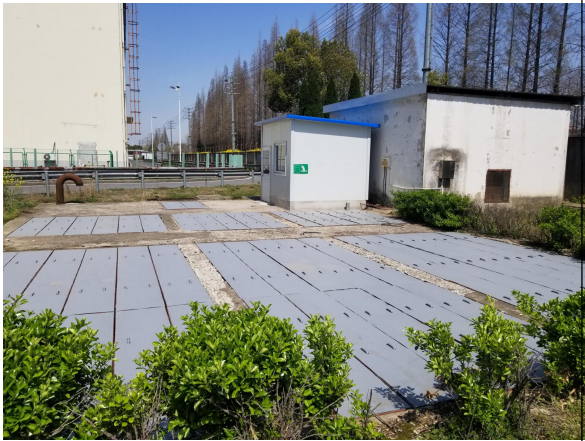
图3-3 雨水排放口标识牌
