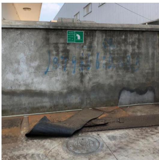
图 3-2 厂区雨水排放口
