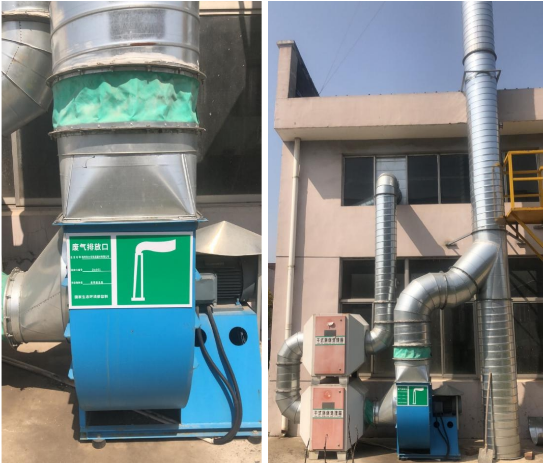
图 3-4 活性炭吸附装置及排气筒标识牌
