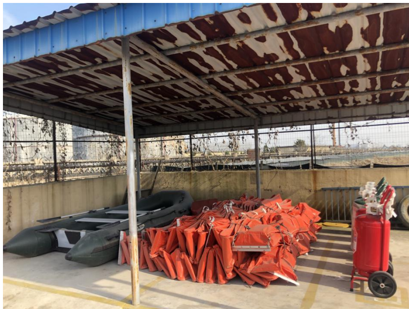
3-2 应急消防设施
