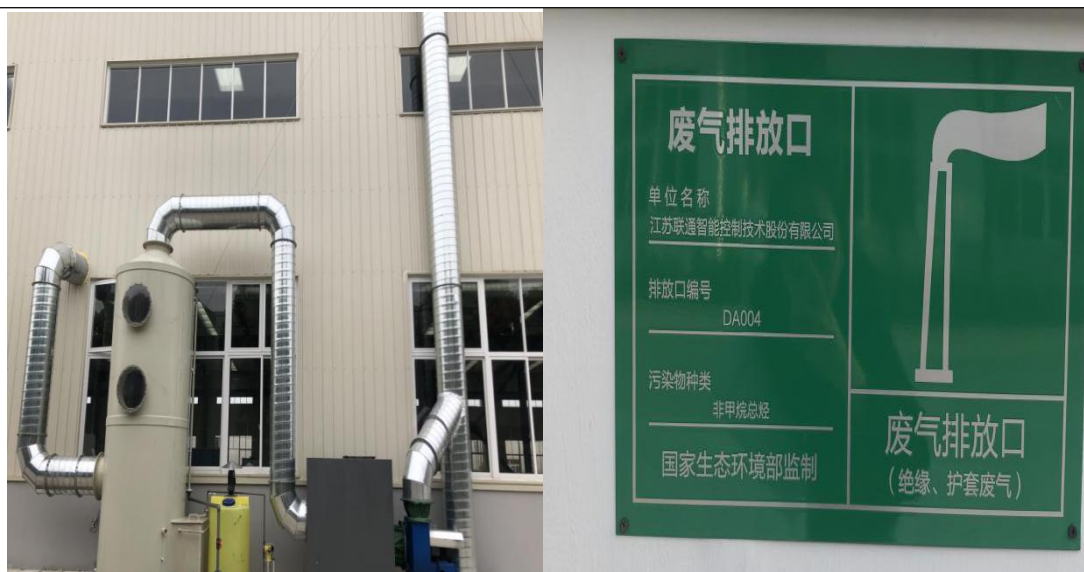
图 3-5 绝缘、护套、喷码废气处置装置及排气筒标识标牌
