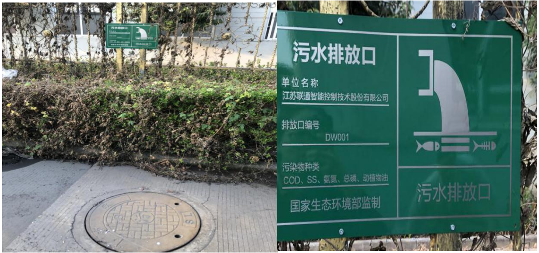
图 3-2 厂区污水排口及标识标牌
