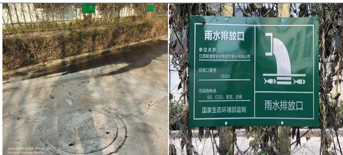
图3-3 厂区雨水排口及标识标牌
