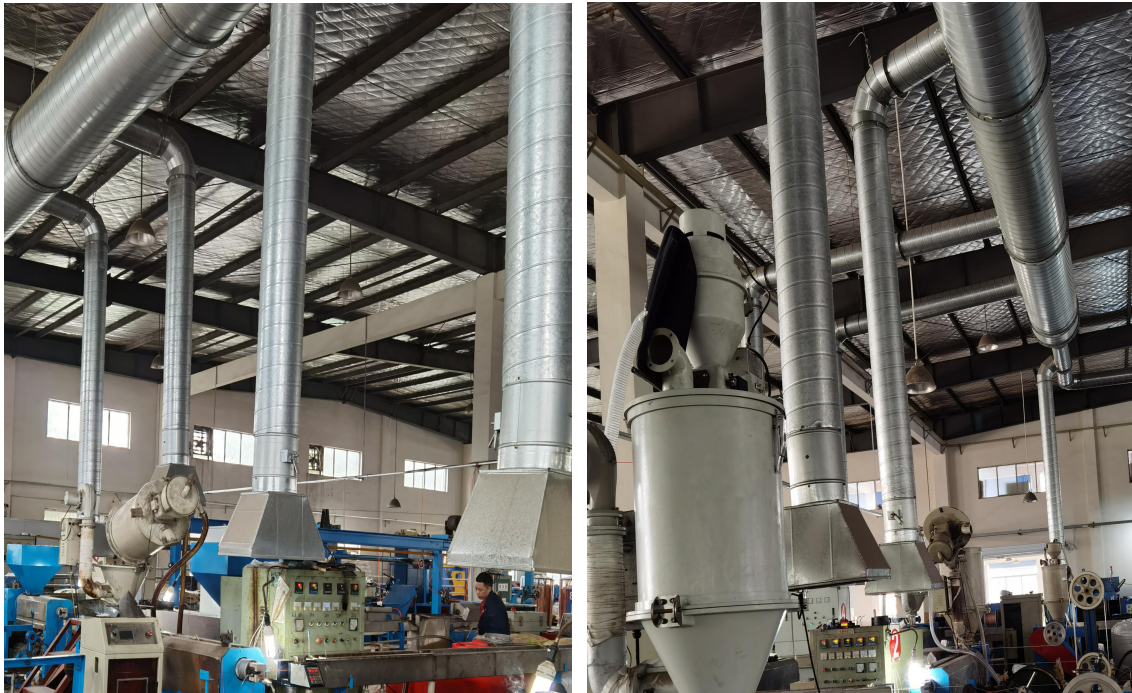
图3-2 车间废气收集
