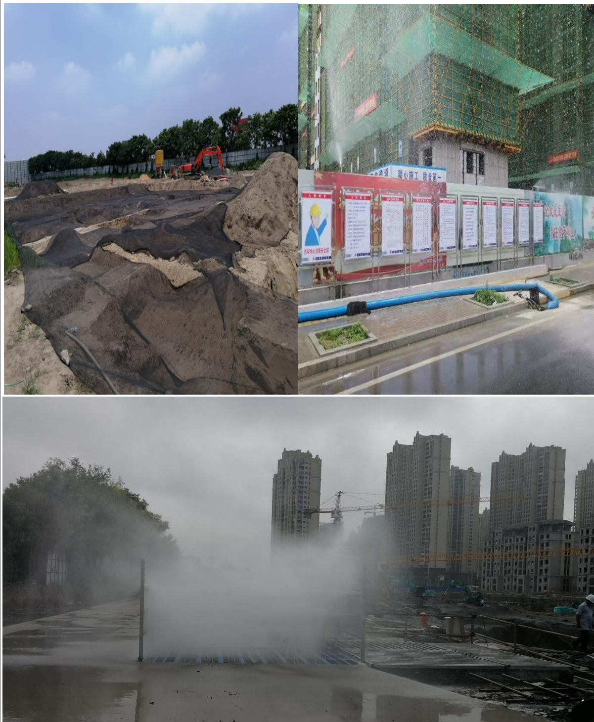
图 3-3 施工期扬尘防治措施
