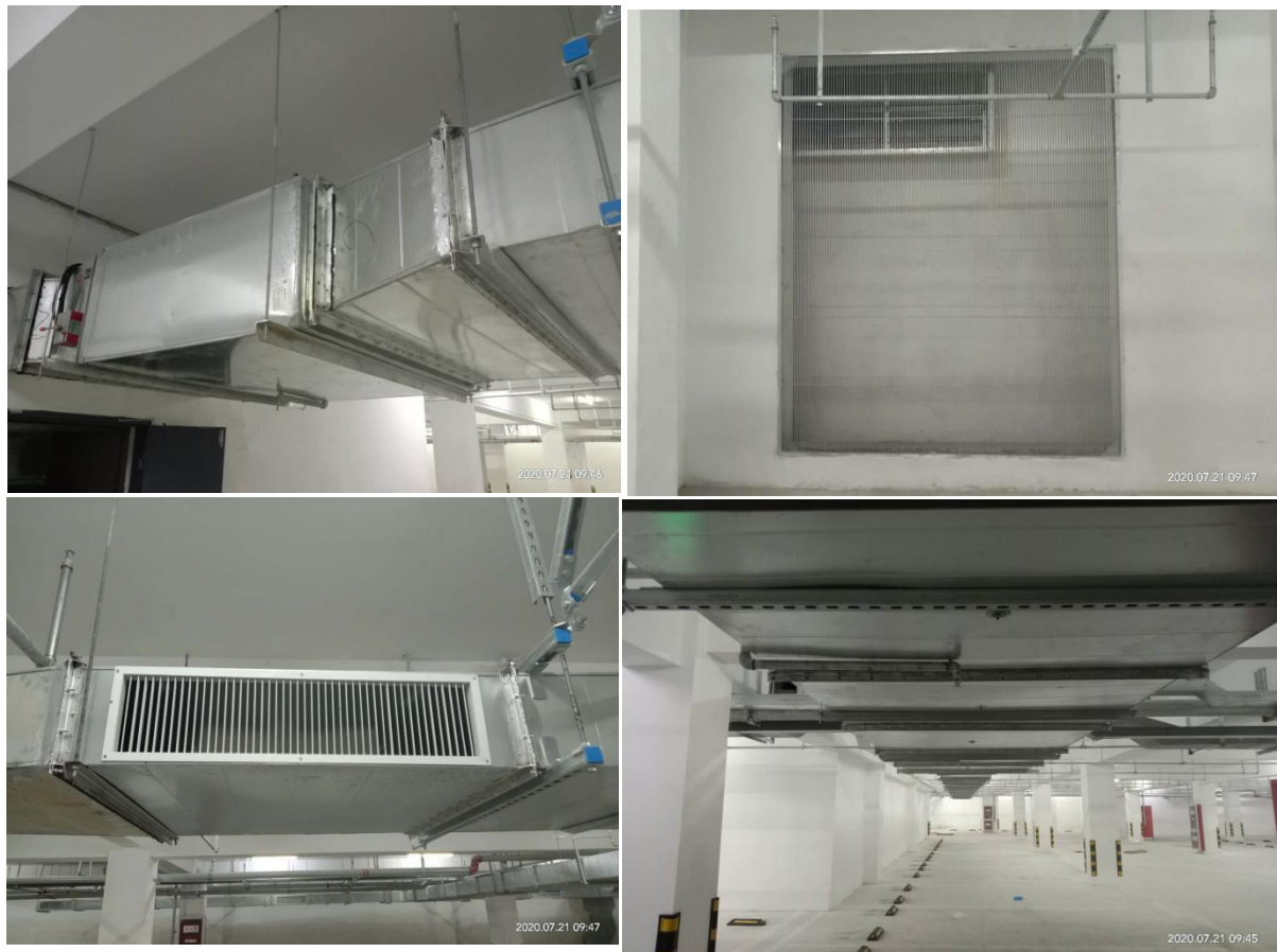
图 3-4 地下车库排风系统及排风口
