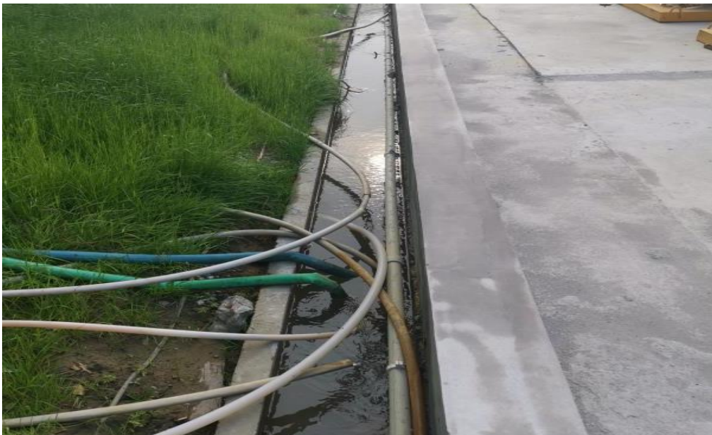
图 3-1 施工期废水收集及回用措施
