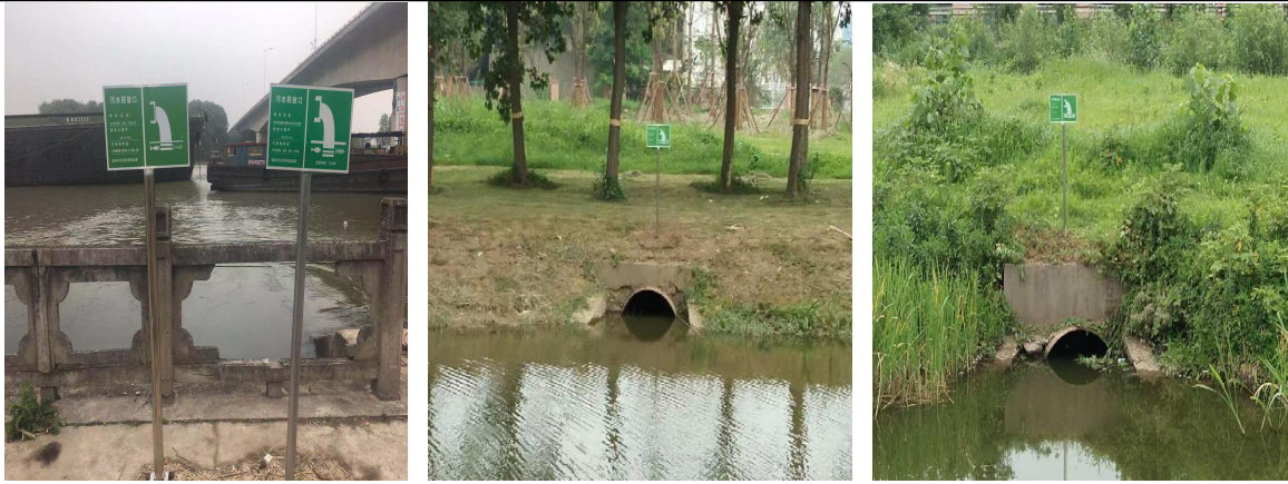
图 3-2 公司污水及雨水排放口
