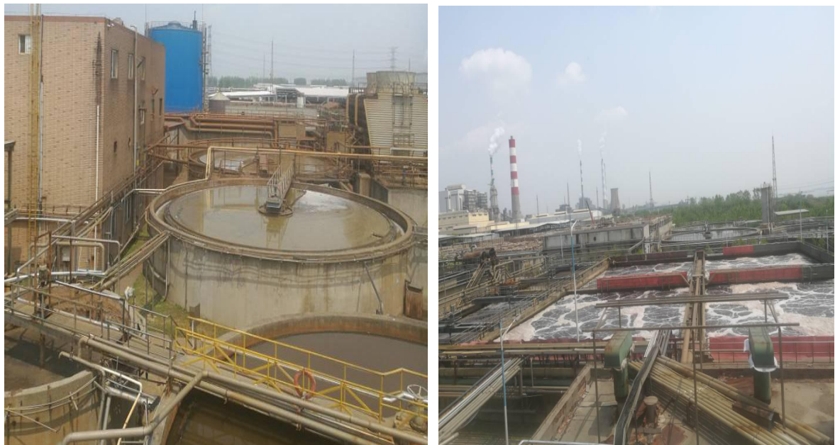
图 3-1 污水处理装置
