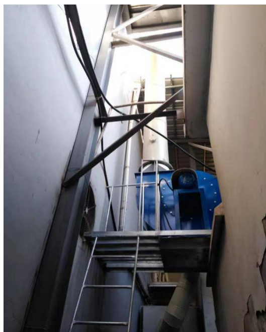
图3-4 (c) 废气活性炭吸附装置及排气筒
