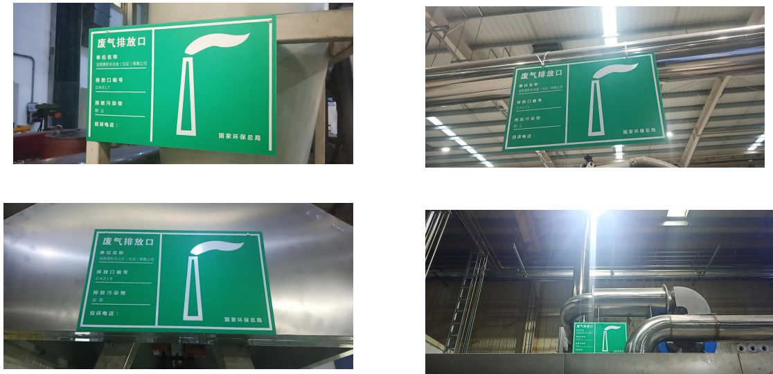
图3-5 废气排放口标识牌
