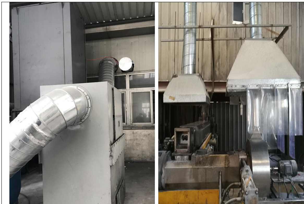
图 3-3 有组织废气收集及处理装置
