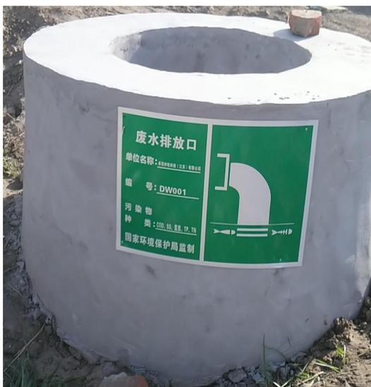
图 3-2 污水接管口
