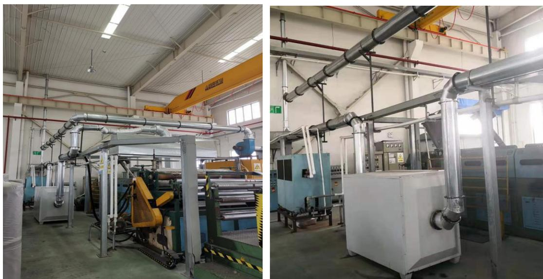
图3-3 边角料回收废气除尘装置及淋膜工序废气活性炭吸附装置
