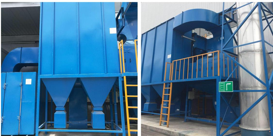
图 3-5 颗粒物及有机废气去除装置
