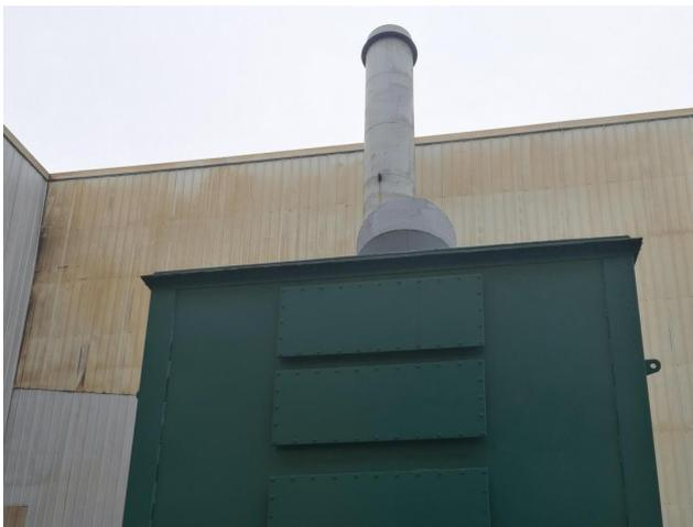
图 10-5 喷漆废气净化装置
